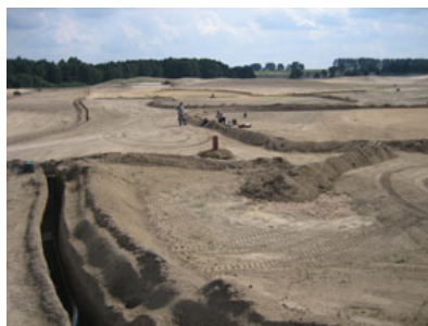
Pokládka drenáží a závlahy
