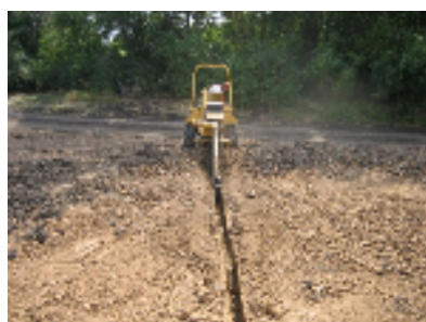
Hĺbenie rýh pre závlahu a drenáž
