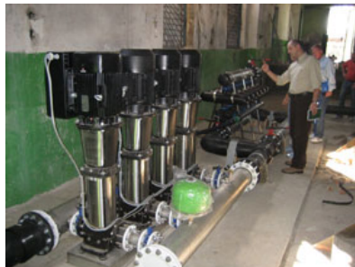
Práce na čerpacej stanici
